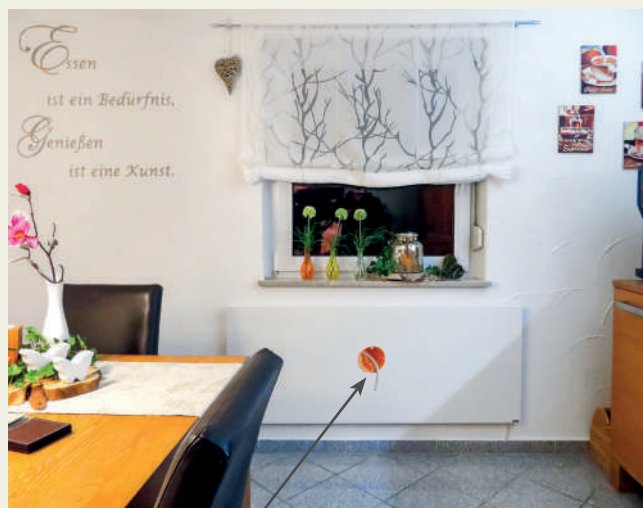
Platzierung der Leerdose mittig hinter der Infrarotheizung
