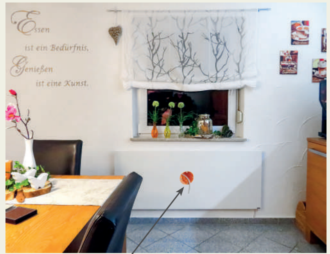
Platzierung der Leerdose mittig hinter der Infrarotheizung
