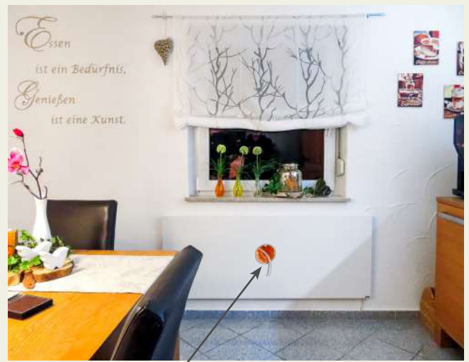
Platzierung der Leerdose mittig hinter der Infrarotheizung
