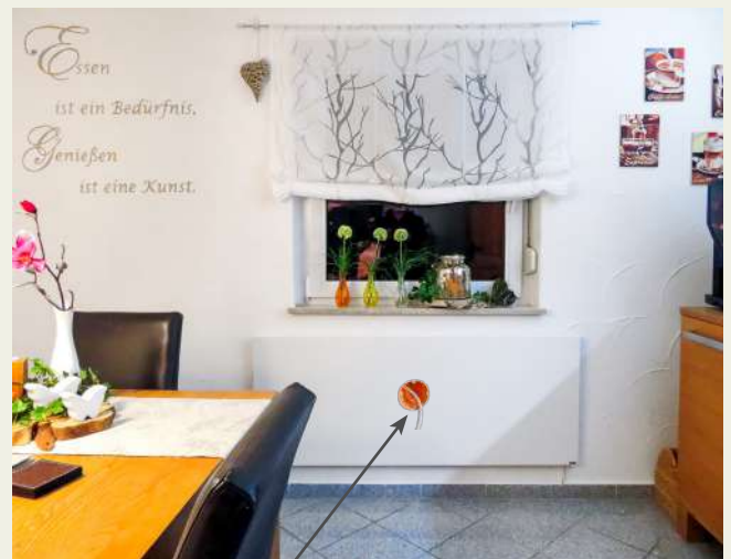
Platzierung der Leerdose mittig hinter der Infrarotheizung
