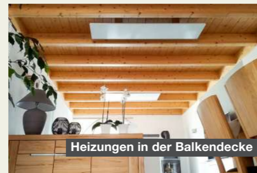
Infrarotheizung im modularen Wohnkonzept der Firma Prinz Holzbau
