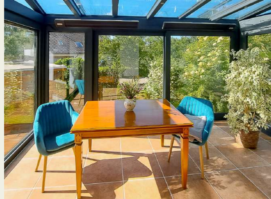
Die HeatShine Infrarotstrahler fügen sich nahezu unsichtbar in den Wintergarten ein.
